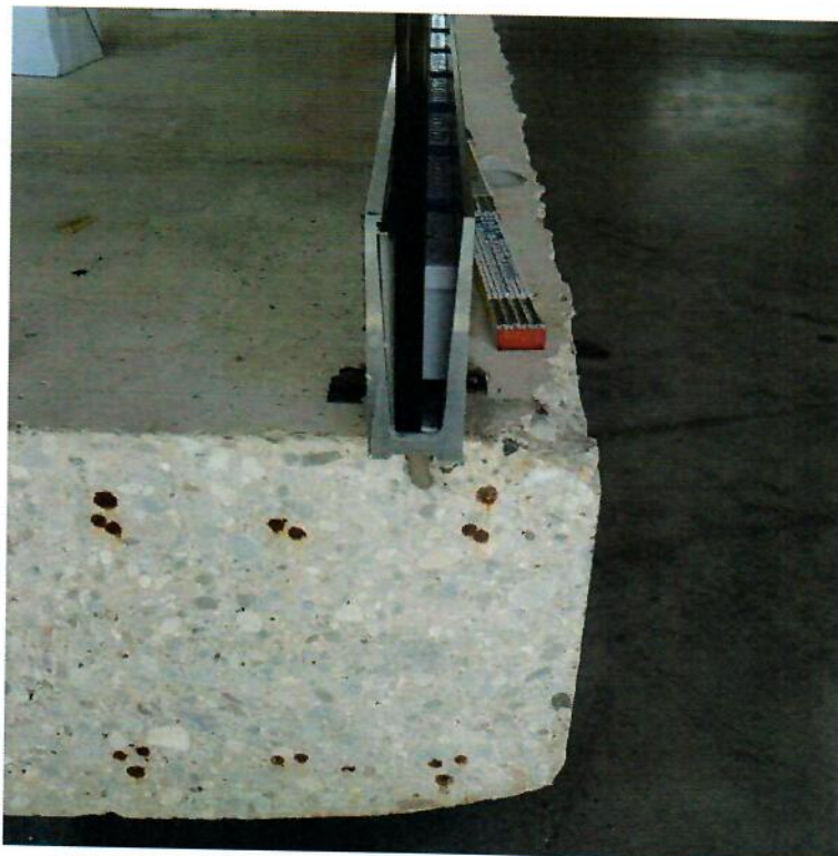
Abbildung V 02-4 Schiene mit eingesetzter Scheibe, Kunststoffwinkeln und Keilen
