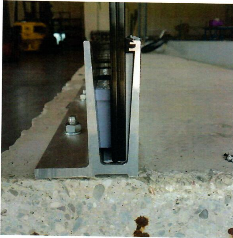
Abbildung V 01-3 Seitenansicht des Profils
