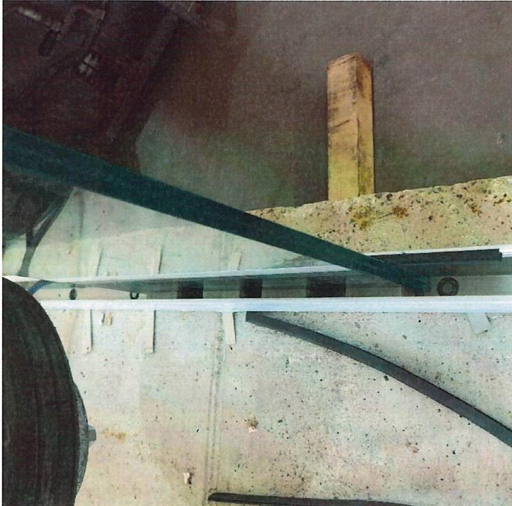
Abbildung V 03-3 Klemmung mit Keilen
