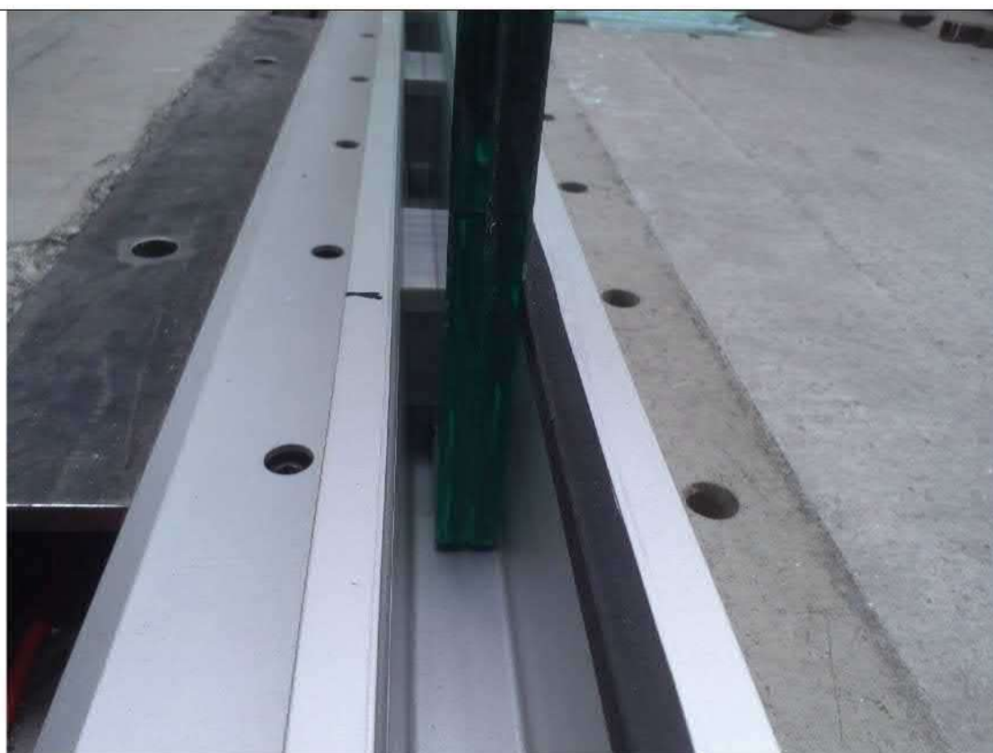
Szczegółowy montaż szkła Fix
