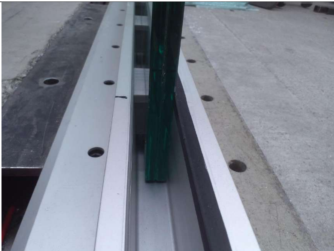
Detailaufnahme Klemmsystem Fix
